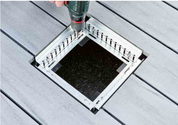
Revisionskasten einsetzen und an Windlastträger verschrauben.
